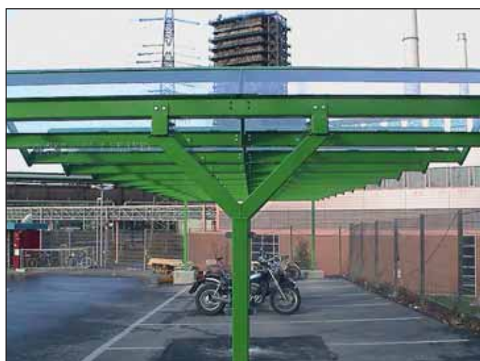
Detail: Y-Rohrstützen
